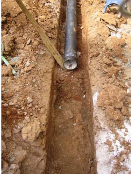
FOTO 9. Instal·lació de tub de servei a la rasa del futur vial de Torres i Amat (R.3)
