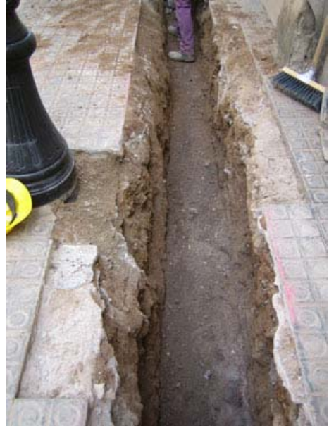
FOTO 10. Vista rasa futur vial de Torres i Amat (R.3)
